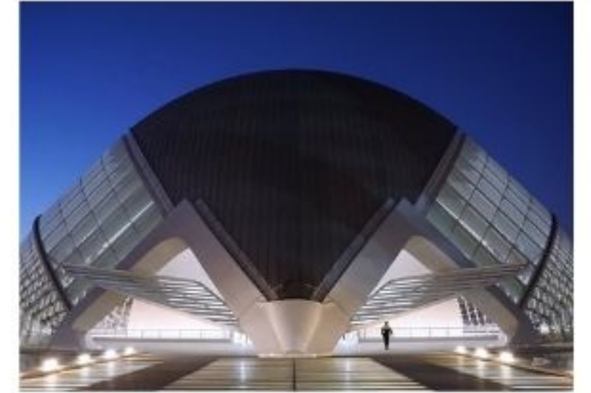
EN LA BOCA DEL LOBO
